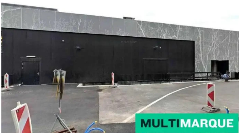
Energie 360° ladestation villars sur glâne
