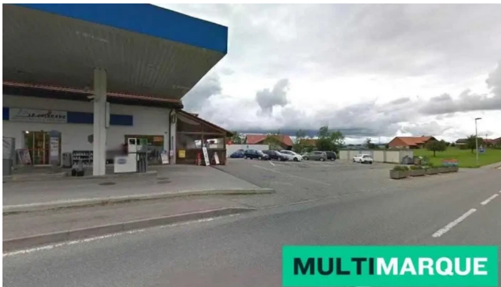
Tankstelle tamoil mezieres mezieres
